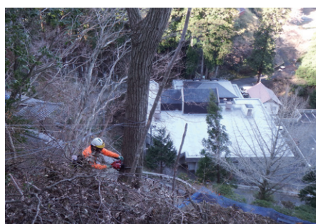
支障木伐採現場
