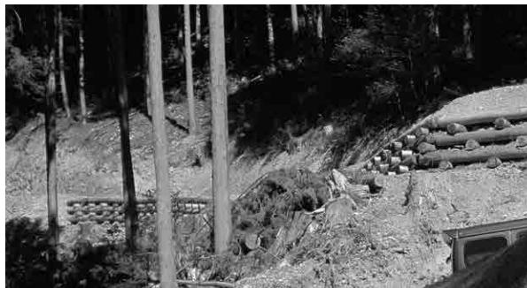
幅員3.6mの4t車通行可能な基幹作業道 かなり切土面が立っていますが、軟弱土ではないので崩土の心配も無いようです。
