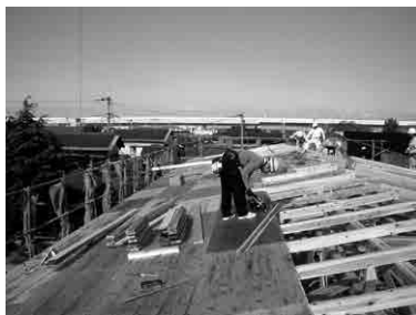
府産材合板の屋根下地
