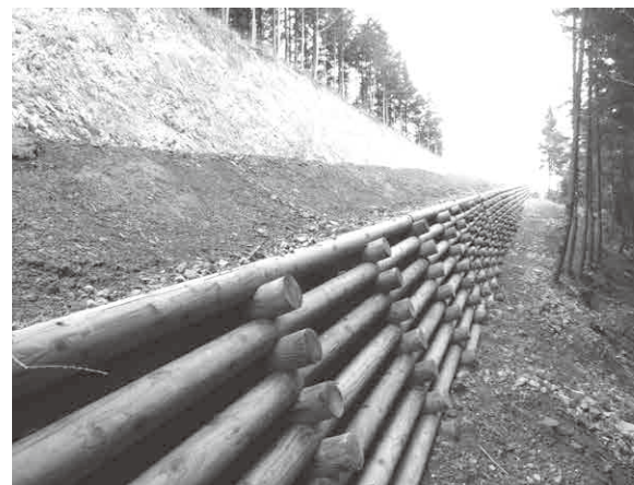
O&D ウッドによる土留工
