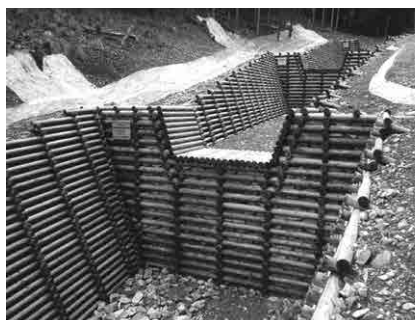
野間地区治山ダムほか(22・奥地)工事 (施工地:能勢町野間稲地)
