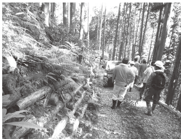
兵庫県神河町にて 経年で植生回復する丸太構造物
